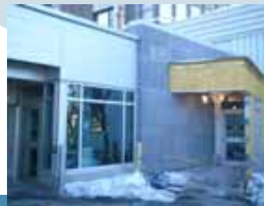
Hôpital Fleury : Construction d'une nouvelle entrée pour l'urgence et rénovation des accès de l'hôpital (± 450 000 $)
